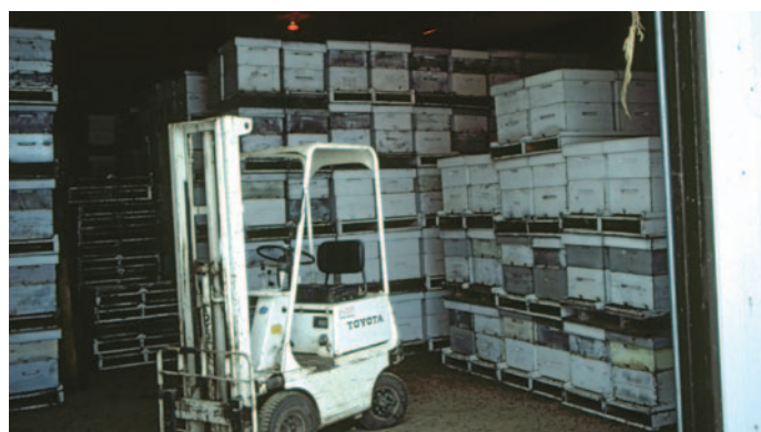
Überwinterung in der Halle ist eine sehr aufwendige Sache. Hier für 1600 Völker in Kanada. Bei Stromausfall sterben die Völker nach etwa 40 Minuten. Denn zwölf große Ventilatoren sorgen für Frischluft, Abluft und die Umwälzung in der gut gedämmten Halle. Neben einer Kühlanlage gibt es auch ein entsprechendes Aggregat für die Luftbefeuchtung, ein Notstromaggregat und eine Alarmanlage.
